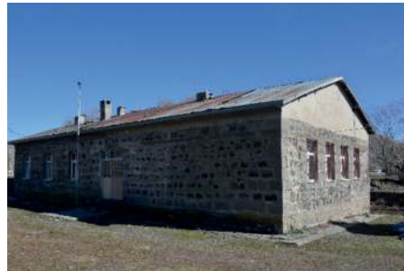
Fotoğraf 6: Bork Köyü İlkokul Binası Güneybatıdan Görünüm (B. Karacabey 2023).
